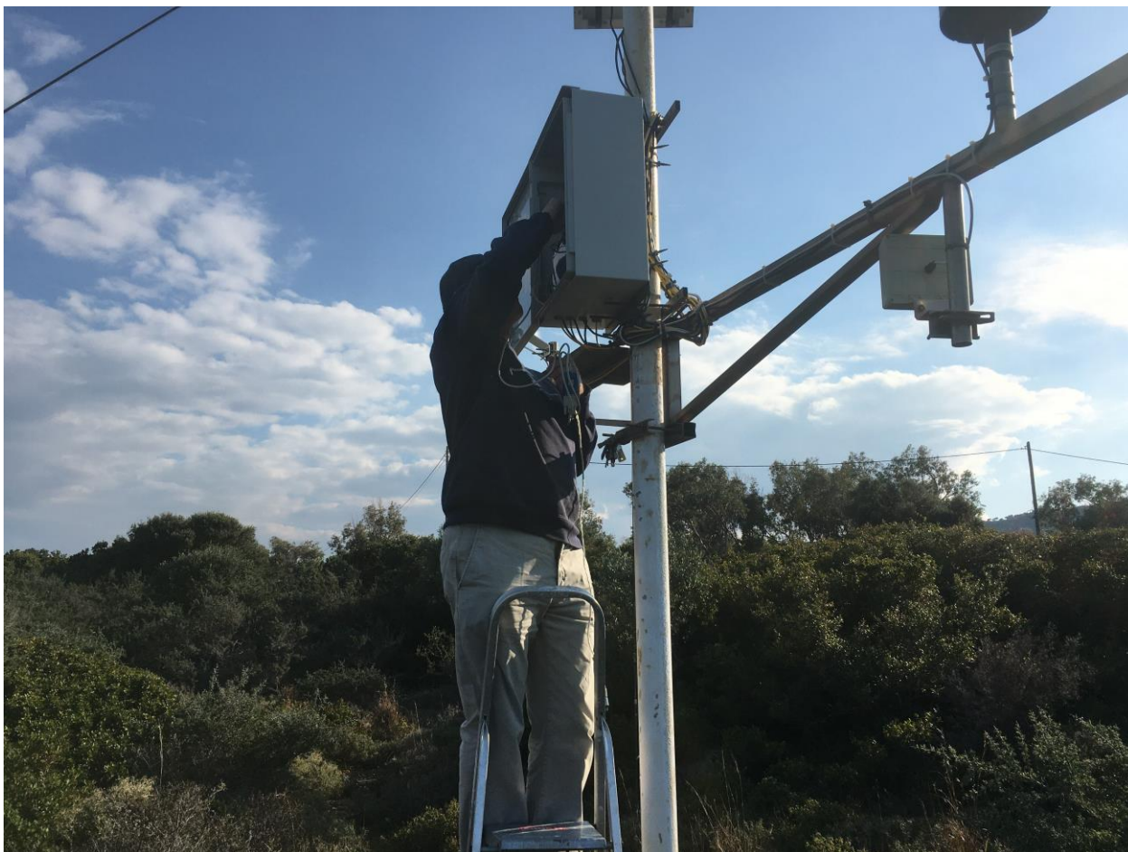
Εικόνα 1.2-2: Απο τις τεχνικές εργασίες στον σταθμό ΖΚΤ-3 στις 13/2/2022.
