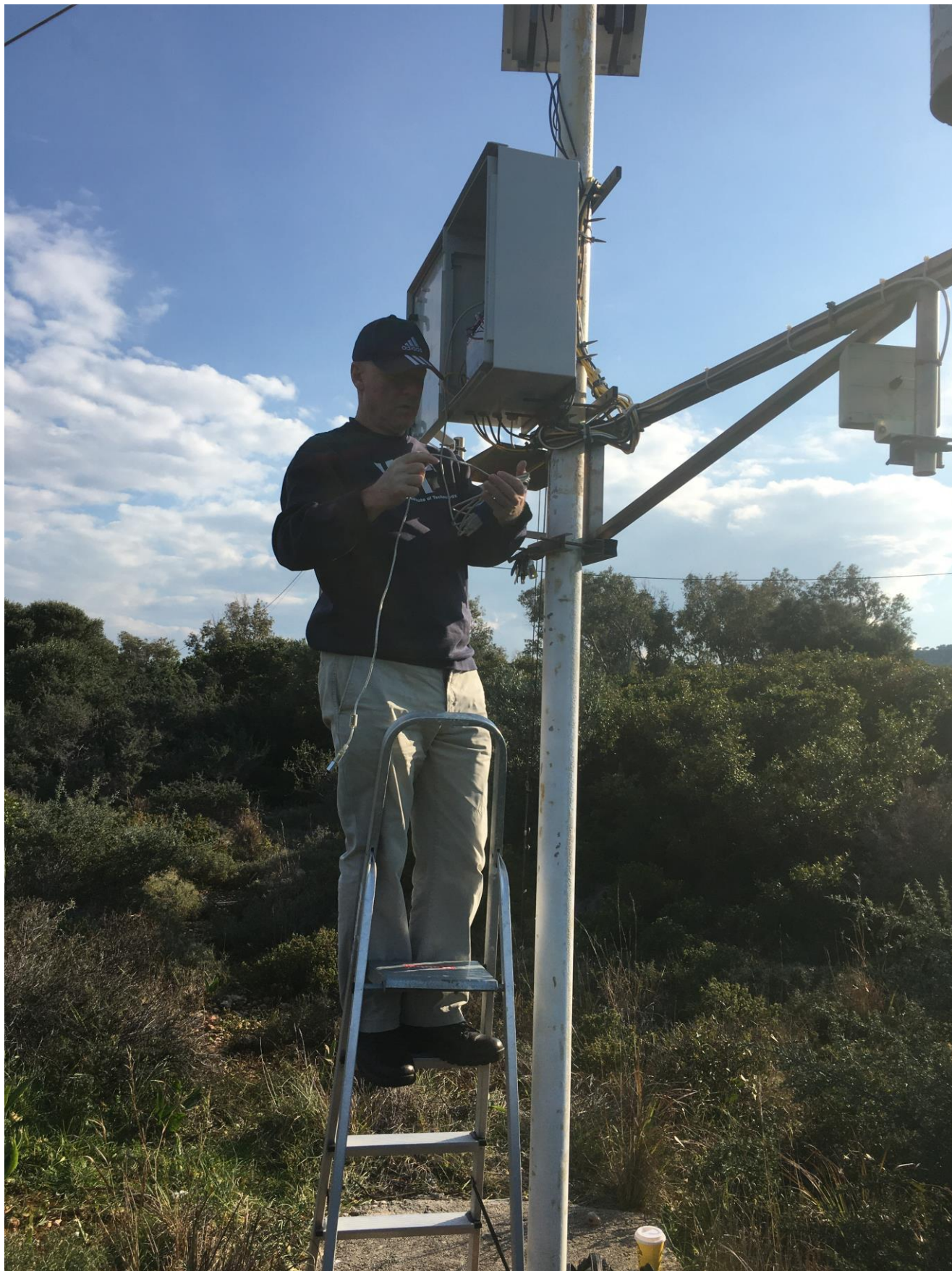
Εικόνα 1.2-3: Απο τις τεχνικές εργασίες στον σταθμό ΖΚΤ-3 στις 13/2/2022.
